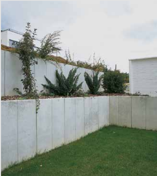
Winkelplatten als Hangsicherung
