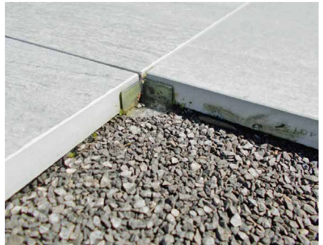
Bild 7: Verlegen der Feinsteinzeug Gehwegplatten in Bettungsschicht
