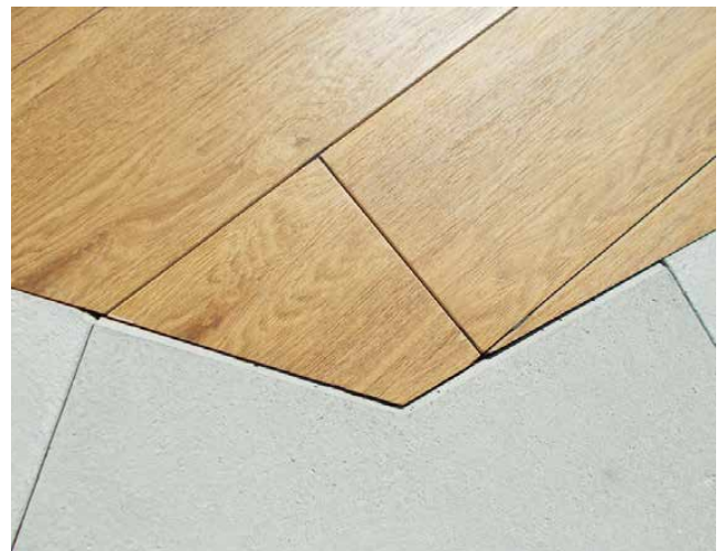
Bild 8: Passstück Feinsteinzeug Gehwegplatte
