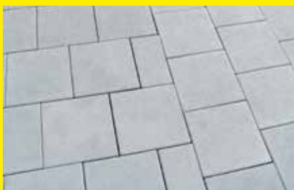
Richtungswechsel der Pflastersteine
