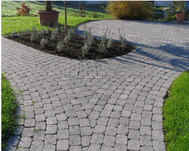
Bild 41: Pflasterfläche mit Passsteinen
