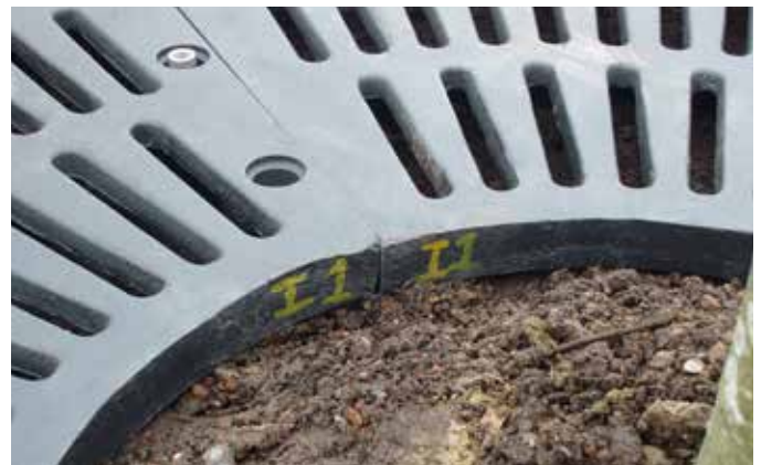
Einfaches Zusammensetzen des 4-teiligen Gussrostes mit den zusammengehörenden Markierungen
