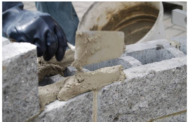
Bild 42: Aufbringen der Mörtelschicht
