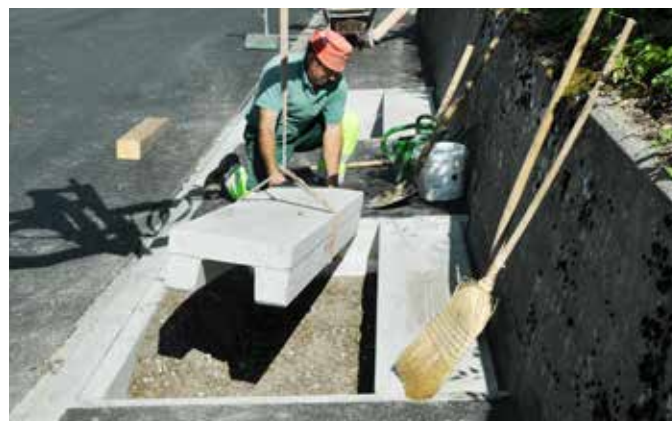
Versetzen der F+F Abdeckelemente
