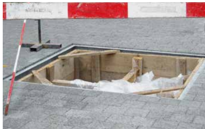
Pflanzgrube mit Fundament und Stahlrahmen
