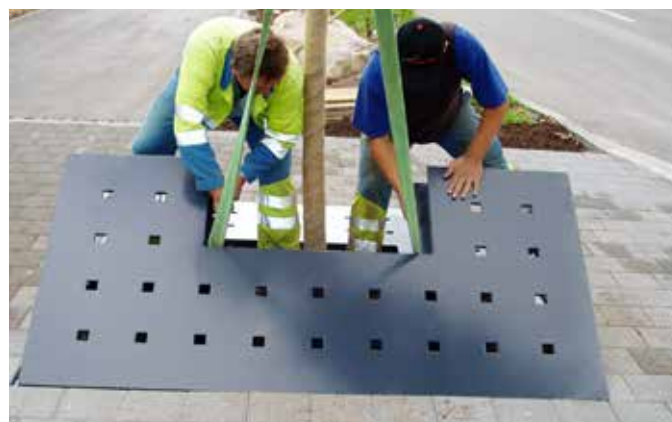
Versetzen der COPAL STEEL Stahlbaumscheibe
