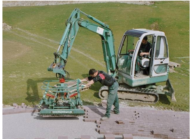
Bild 38: Verlegemaschine im Einsatz
