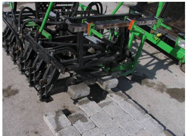
Bild 39: Maschinelle Verlegung mit OPTIMAS Verlegemaschine
