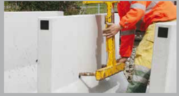
VERSETZGERÄTE FÜR PERRONWINKEL
