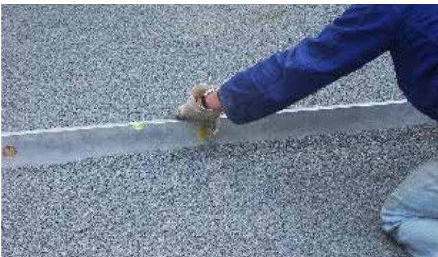
Bettungsschicht abziehen
