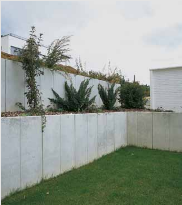
Winkelplatten als Hangsicherung
