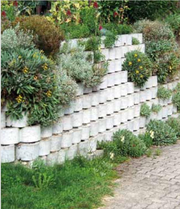
Begrünbare (offene) Hangsicherung
