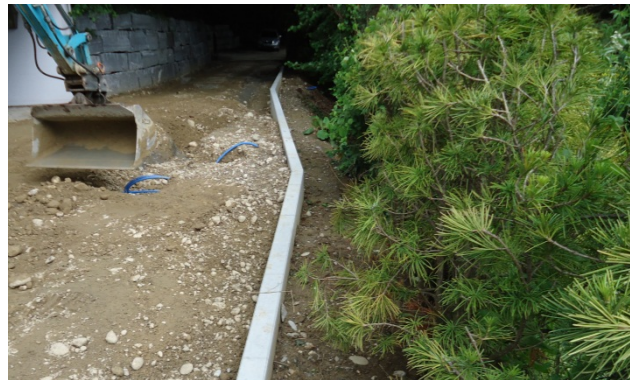
Bild 41: Lagenweises Einbringen von geeigneten Hinterfüllmaterial
