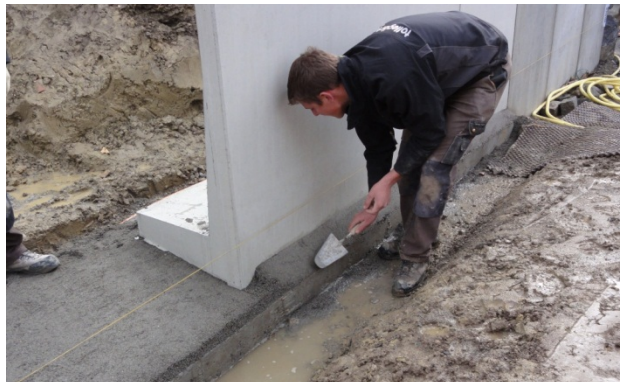
Bild 37: Erstellen der Fundamentnocken
