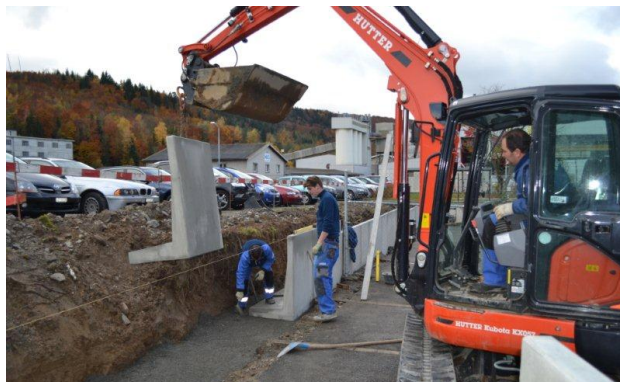
Bild 35: Versetzen der Winkelplatten
