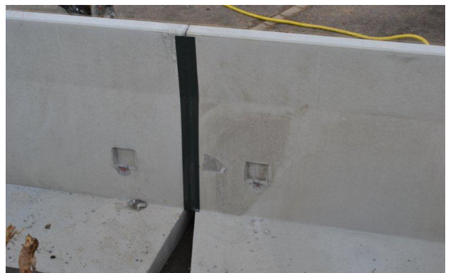
Bild 40: Abdichten der Fugen
