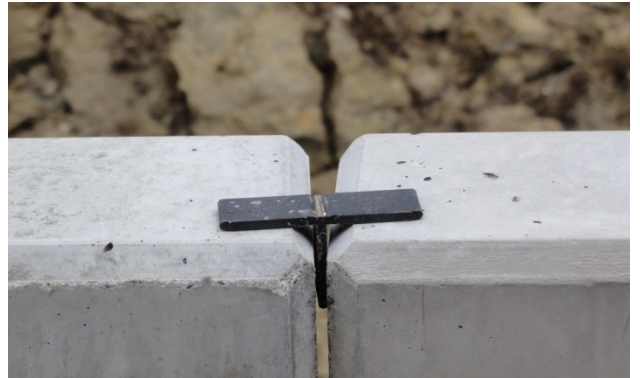
Bild 39: Optimale Fugen nach der Versetzung
