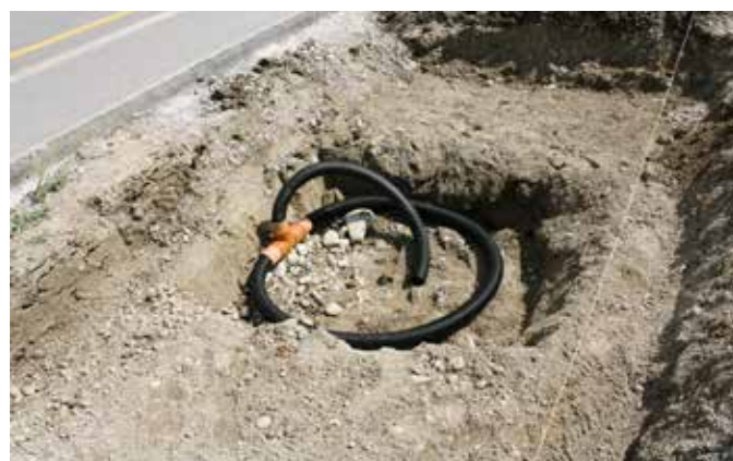
Vorbereitete Sickerrohre in der Baumgrube
