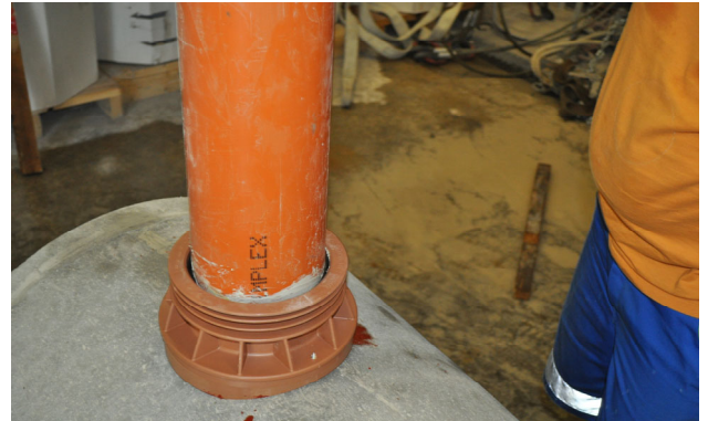
Bild 14: Anschlussrohr anschliessen
