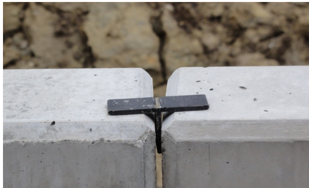
Bild 39: Optimale Fugen nach der Versetzung
