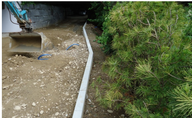
Bild 41: Lagenweises Einbringen von geeignetem Hinterfüllmaterial
