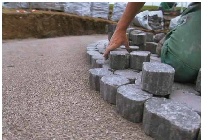
ARENA Vista® Pflastersteine werden von Hand verlegt
