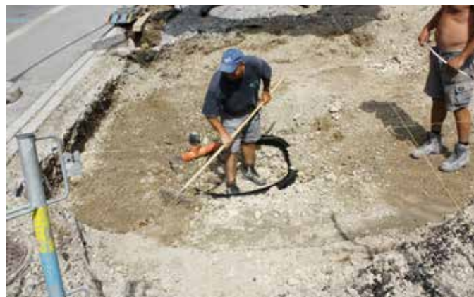
Erstellen der Auflageflächen
