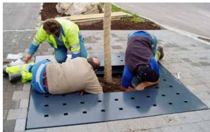
Montieren der Verbindungsschrauben
