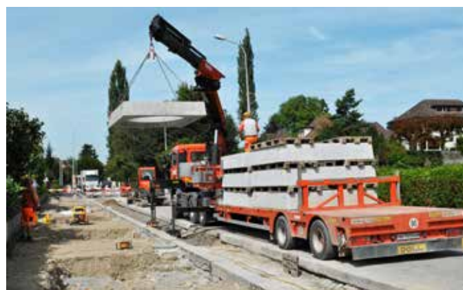
Transport auf der Baustelle mit Lieferfahrzeug
