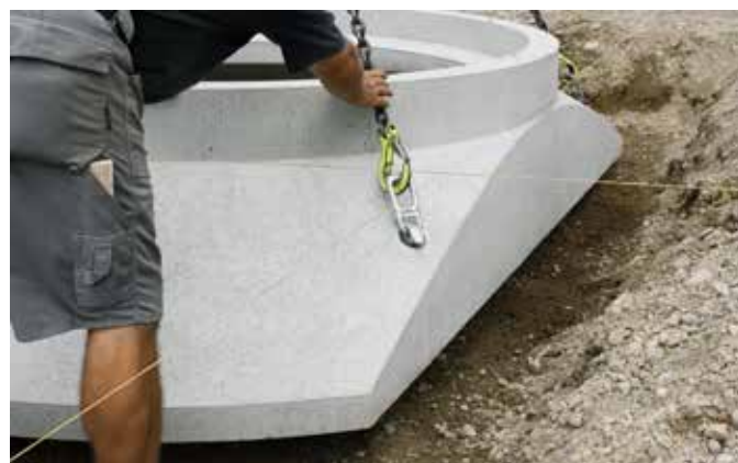
Versetzen des Basiselementes
