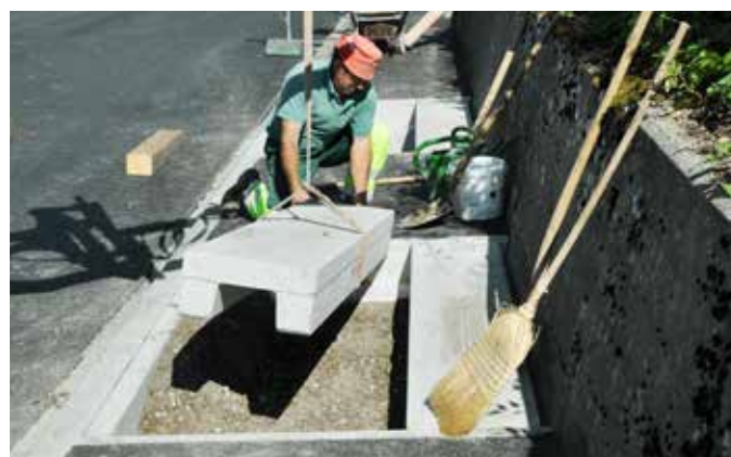
Versetzen der F+F Abdeckelemente
