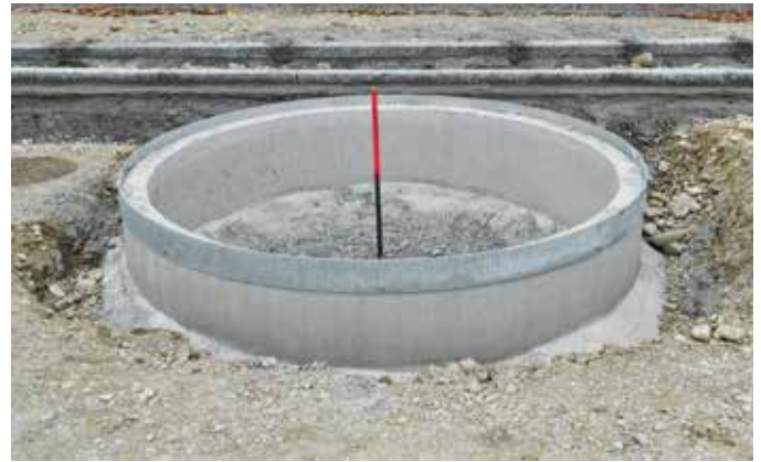
Montierter Stahlleinbaurahmen mit Bolzenanker
