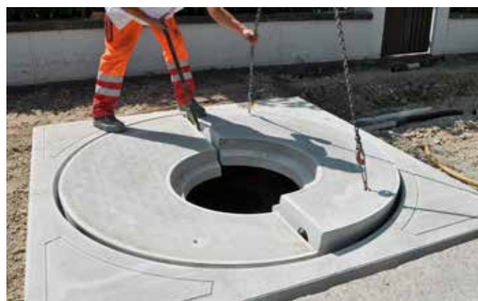
Versetzen der COPAL Betonabdeckung
