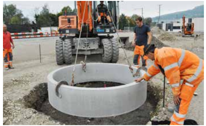
Versetzen des TREETUB Betonrohres auf das Streifenfundament
