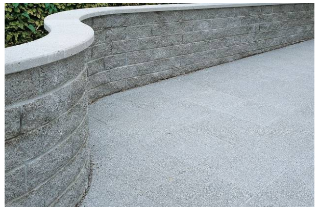
Bild 3: Mauer mit Radiusspaltsteinen
