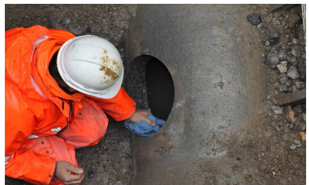
Bild 7: Bohrloch reinigen
