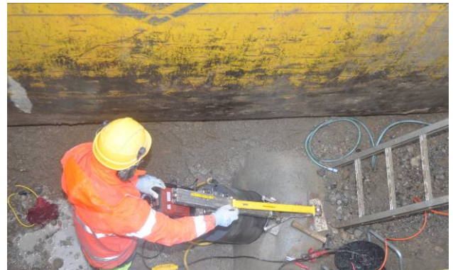
Bild 6: Korrekt montiertes Kernbohrgerät
