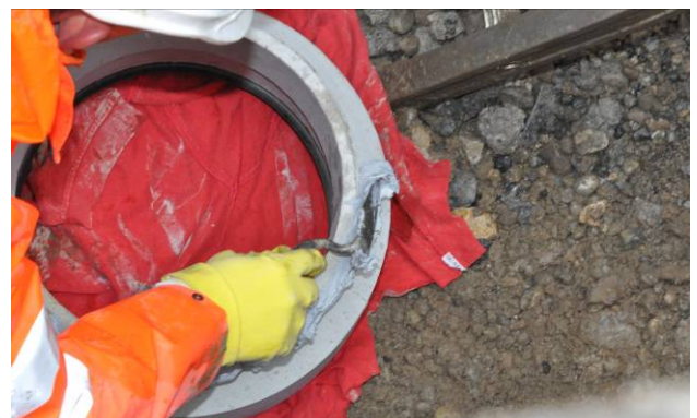
Bild 9: Auftragen der Klebmasse auf den Schaft
