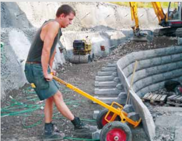
Einfaches Versetzen mit Handwagen
