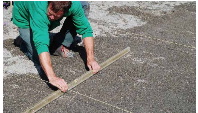
Abziehen der Bettungsschicht
