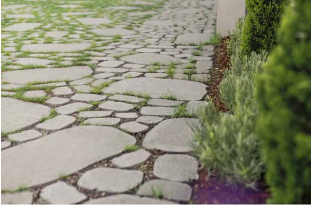
Fugenbefüllung mit Splitt, Sand/Splittgemisch, Substrat
