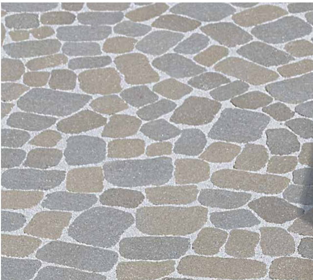
Fugen Befüllung mit Epoxidharzgebundenen Fugenmörteln (z. B. Rompox Drain od. D1)
