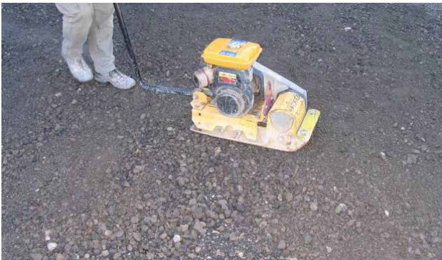
Verdichten der Fundationsschicht
