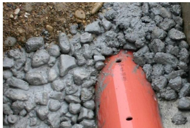
Bild 33: Eingebaute Sickerleitung
