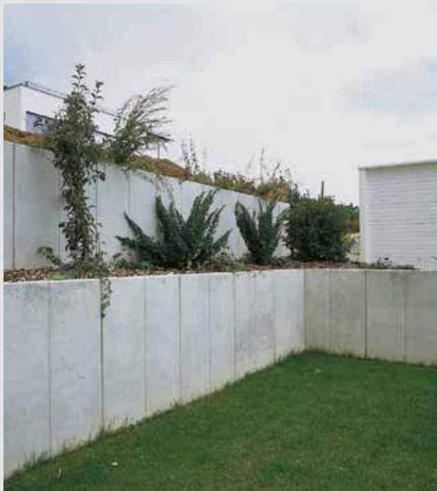
Winkelplatten als Hangsicherung
