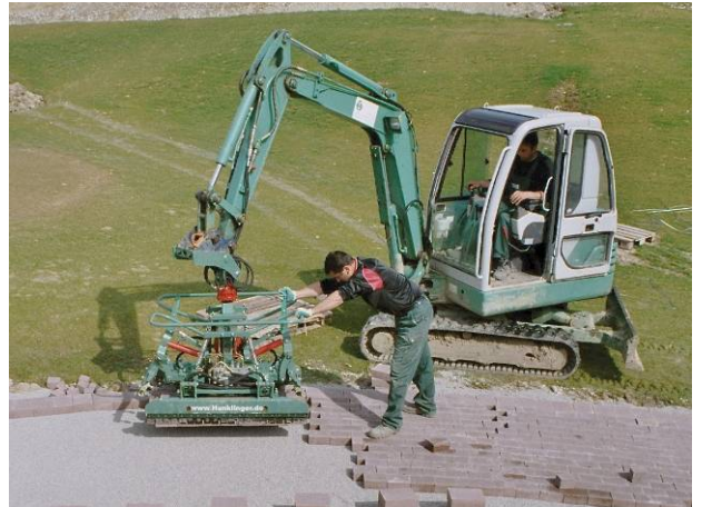
Bild 38: Verlegemaschine im Einsatz
