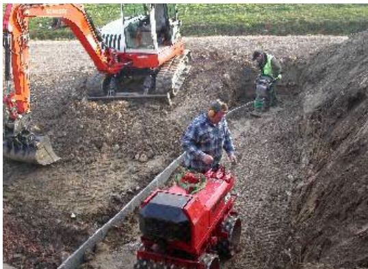
Bild 21: Verdichten mit Schaffusswalze
