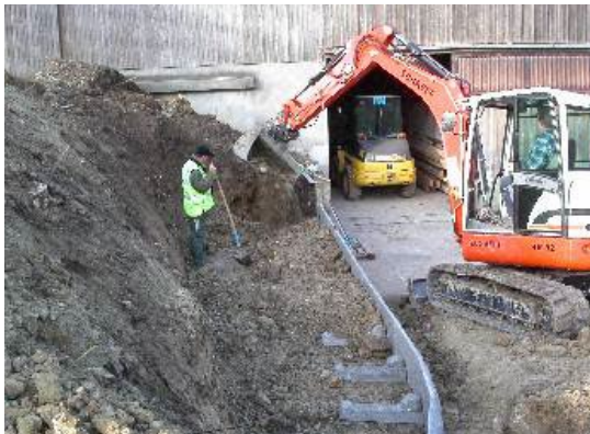
Bild 20: Hinterfüllen der ersten 20 cm
