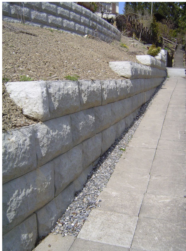
Bild 47: seitlicher Abschluss der Abtreppungen mit Ecksteinen
