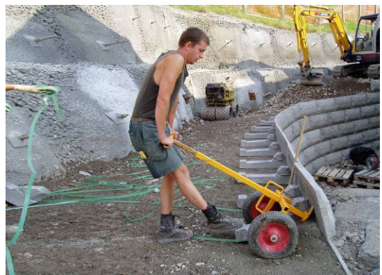
Bild 17: LOCK+LOAD Versetzwagen
