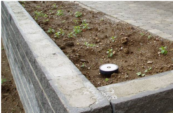
Bild 61: Vorbereitete Mauerkrone
