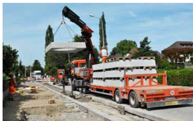
Transport auf der Baustelle mit Lieferfahrzeug
