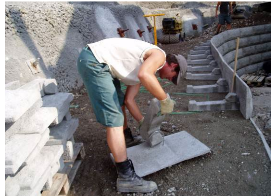
Bild 15: Frontplatte mit Anker verbinden
