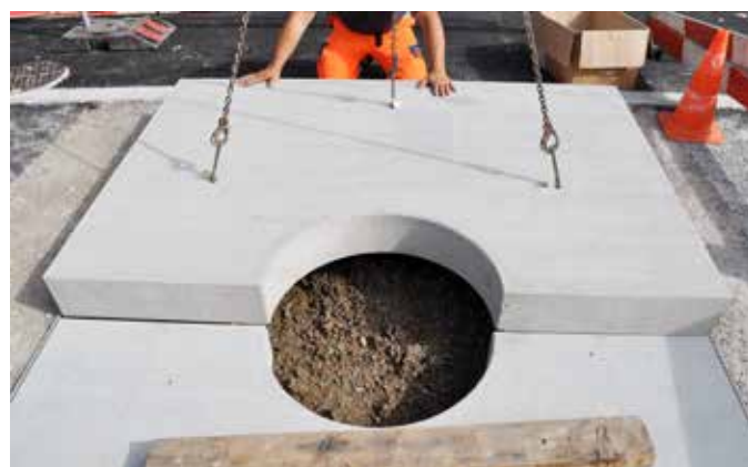
Versetzen der BAUMFIX® Baumscheiben
