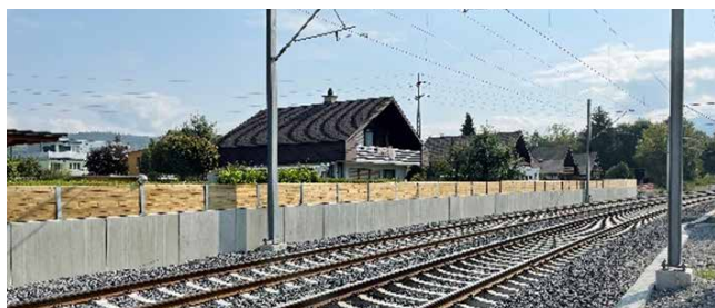
GRANDE Winkelplatten im Bahnbereich
