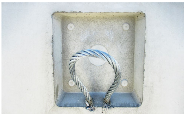
Bild 30: Werkseitig eingebaute Seilschlaufen
