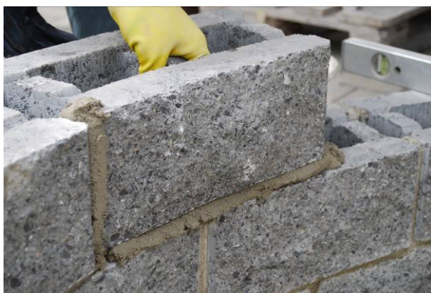
Bild 57: Versetzen von Radiussteinen
