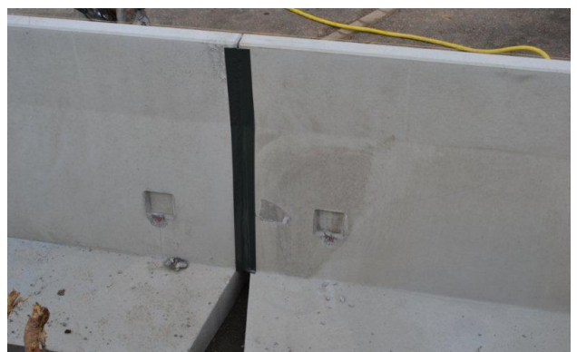
Bild 40: Abdichten der Fugen
