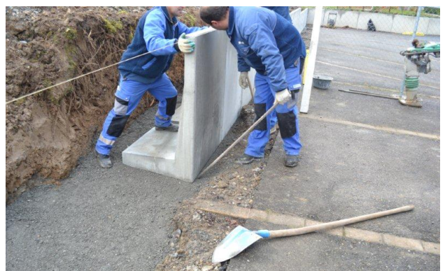
Bild 36: Richten der Winkelplatte
