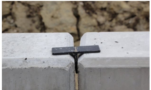
Bild 39: Optimale Fugen nach der Versetzung
