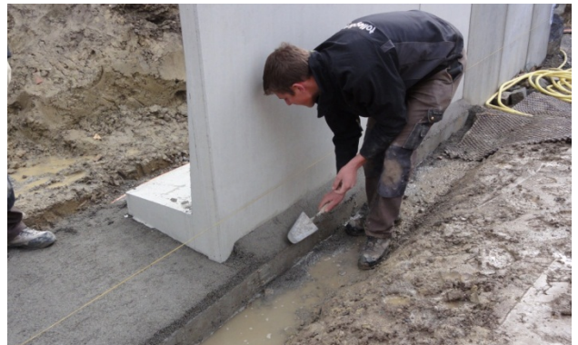
Bild 37: Erstellen der Fundamentnocken
