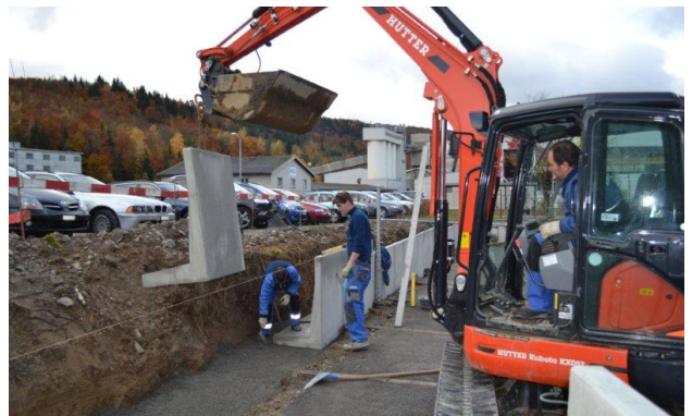
Bild 35: Versetzen der Winkelplatten
