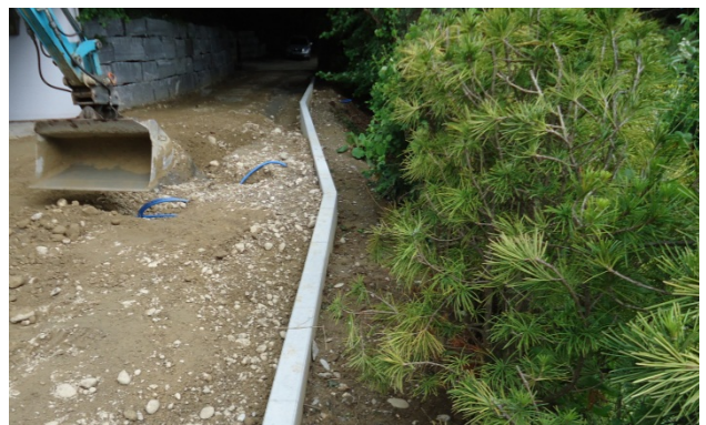
Bild 41: Lagenweises Einbringen von geeigneten Hinterfüllmaterial
