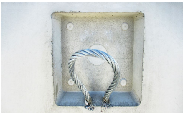
Bild 30: Werkseitig eingebaute Seilschlaufen
