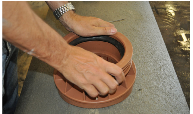
Bild 12: Steckanschlussstück einpressen
