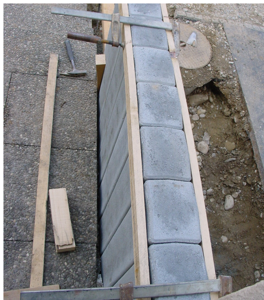
Bild 13: Gesicherte Palisaden
