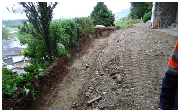
Bild 22: Erstellen der Sauberkeitsschicht
