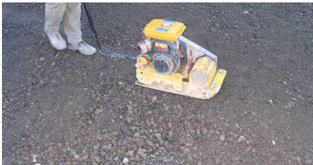
Verdichten der Fundationsschicht
