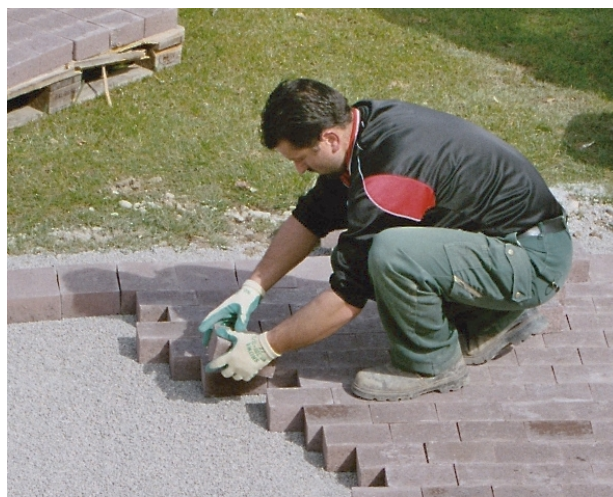
Bild 35: Verlegung der Steine von Hand
