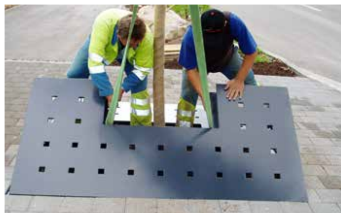
Versetzen der COPAL STEEL Stahlbaumscheibe
